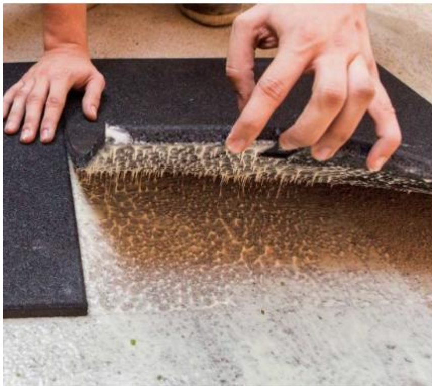
Imagem ilustrativa aplicação da cola PU.
