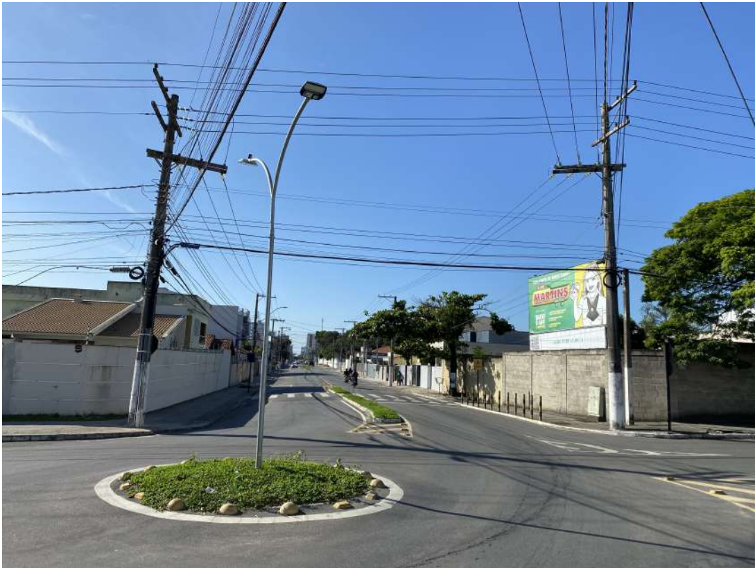
Foto 25 – Visada 02, atual, vista a partir do Bairro Conceição, no ponto de encontro da Avenida Guerino Giubert com a Avenida Nogueira da Gama.
