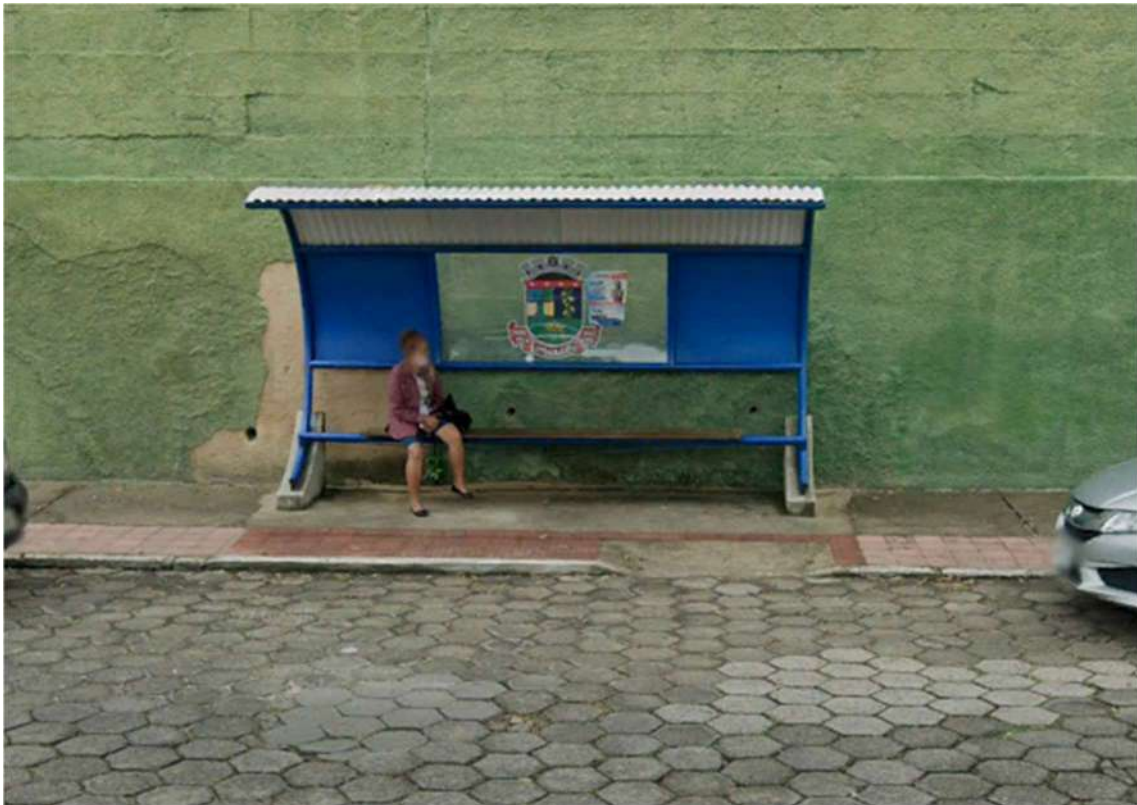
Foto 19 – Abrigo 04 – Avenida Ibirapu.
