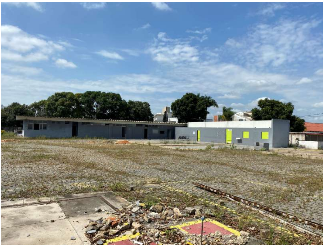
Foto 03: Pátio principal, terreno abandonado.
