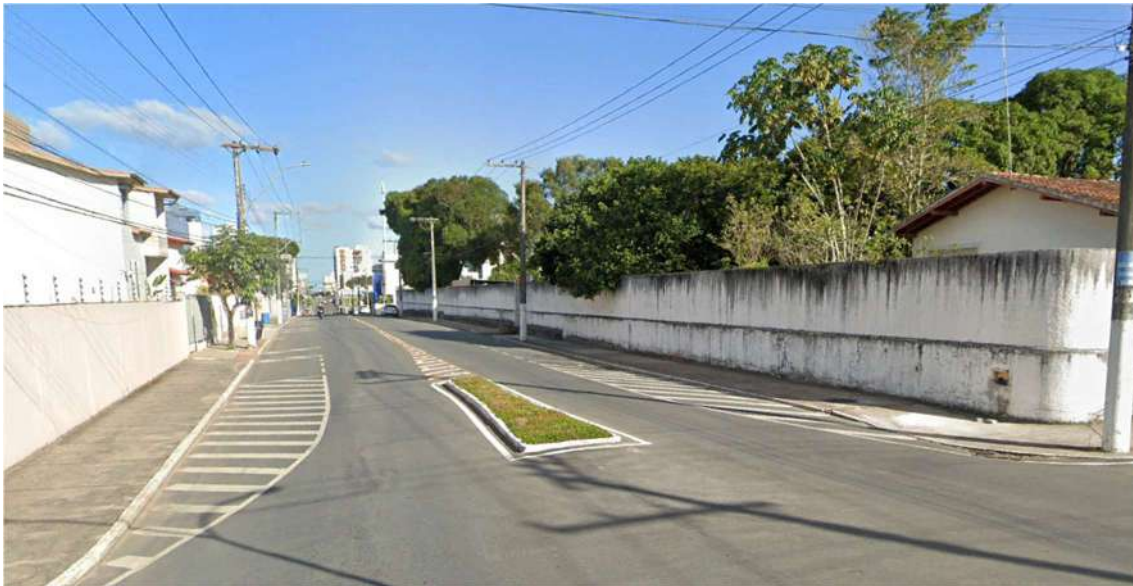
Foto 08: Avenida Nogueira da Gama (sentido Centro).
