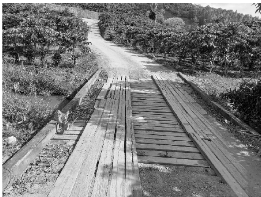
Foto 08: Ponte de Pedrolândia.
