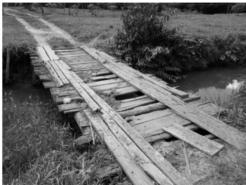
Foto 06: Ponte de Bom Parto.
