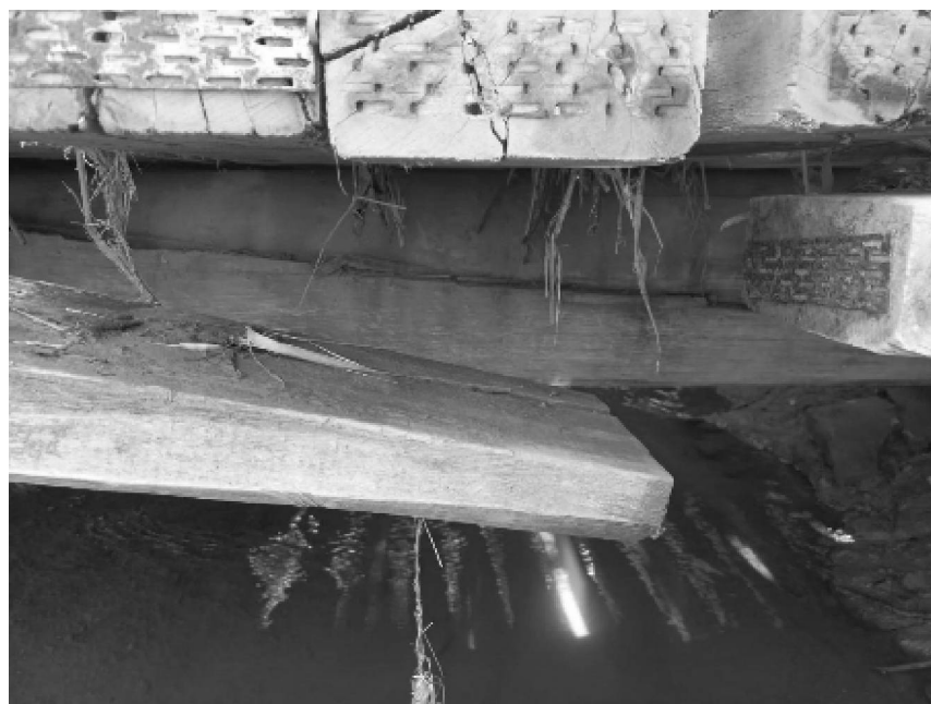
Foto 09: Ponte de Serra da Balança.
