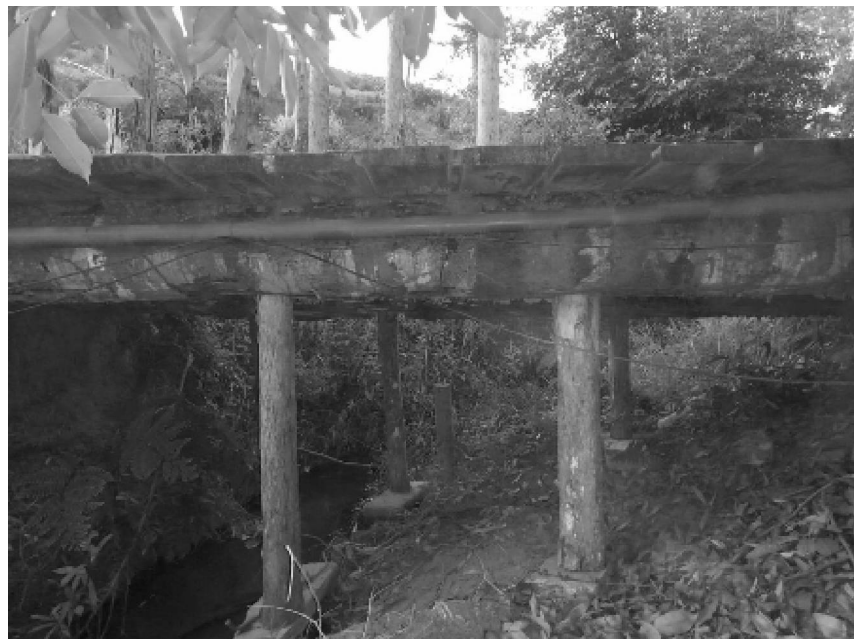
Foto 05: Ponte de São Vicente de Terra Alta.
