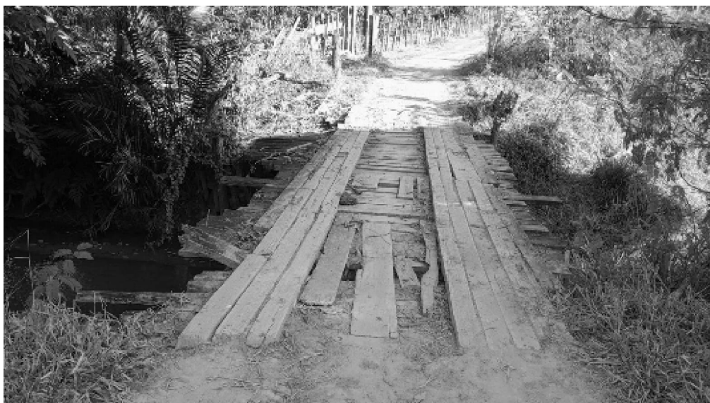
Foto 04: Ponte de Serra da Balança.
