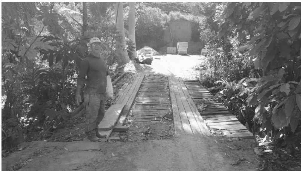
Foto 03: Ponte de São Rafael.
