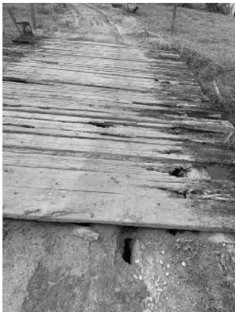
Foto 07: Ponte de Pedrolândia.
