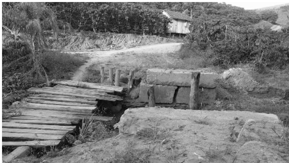
Foto 01: Ponte de Santa Cruz de Terra Alta.
