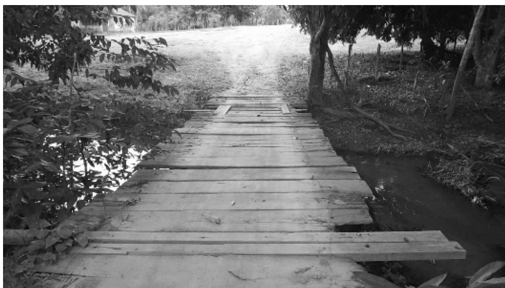
Foto 02: Ponte de São Vicente de Terra Alta.
