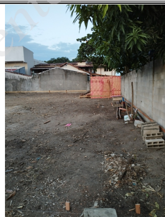
Imagem 04: Imagem da situação interna do lote já com construção iniciada, marcação de gabarito e cômodo de guardar material e ferramentas sendo erguido.
