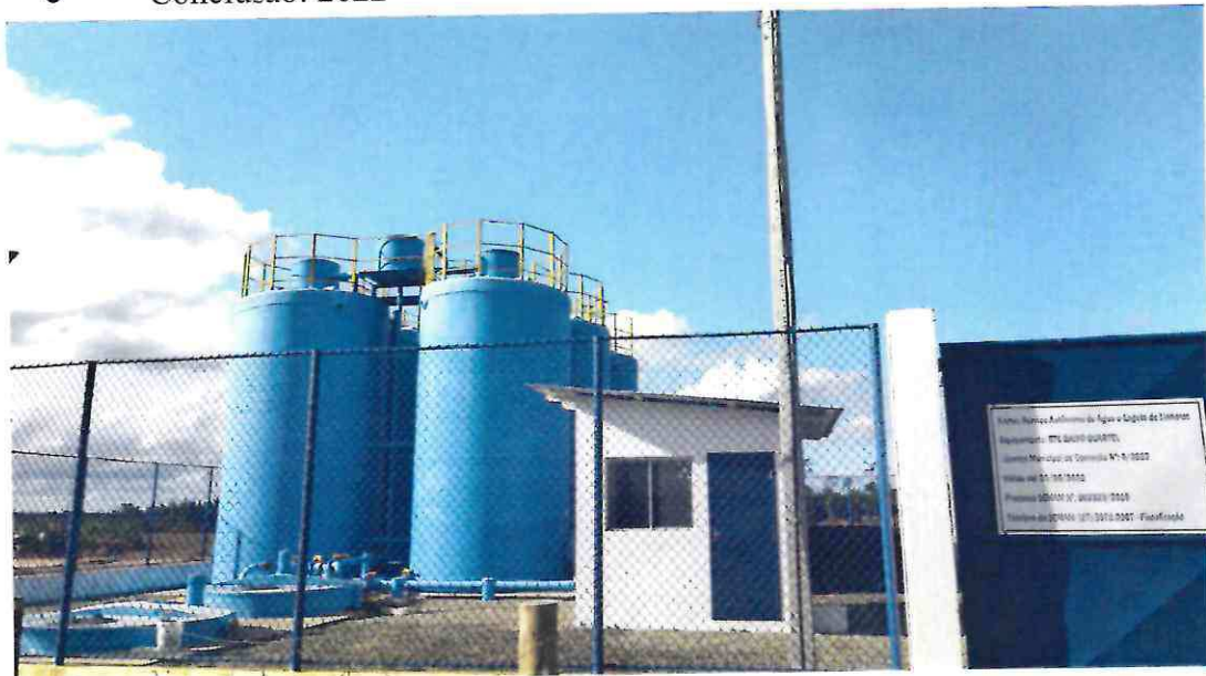
ETE Baixo Quartel
