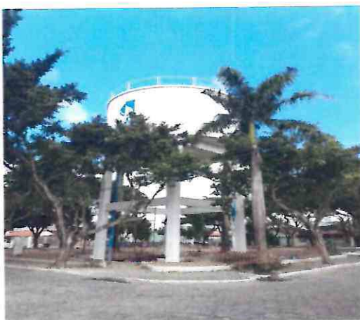
Reservatório Elevado – Juparanã
