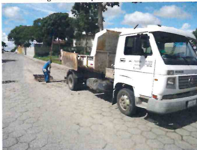
Figura 18: Limpeza de boca-de-lobo.
