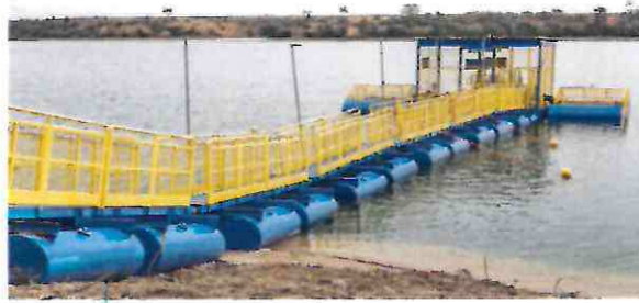
Captação de Água Lagoa Nova
