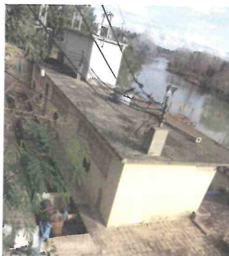
Captação de Água Bruta
