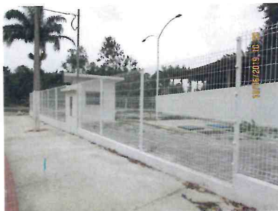
Elevatória Bairro Lagoa do Meio
