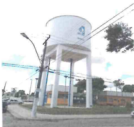
Reservatório Elevado - Shell
