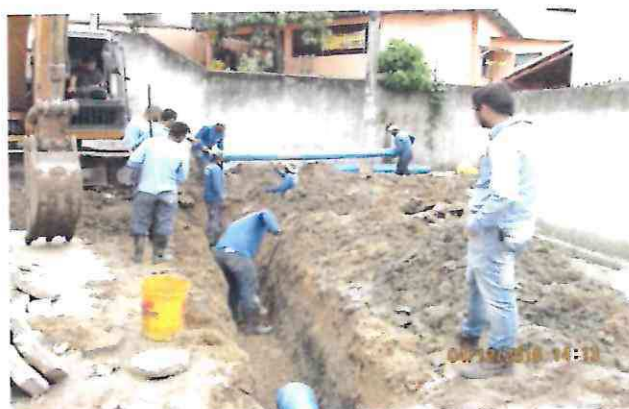
Execução de serviço de abastecimento de Água
