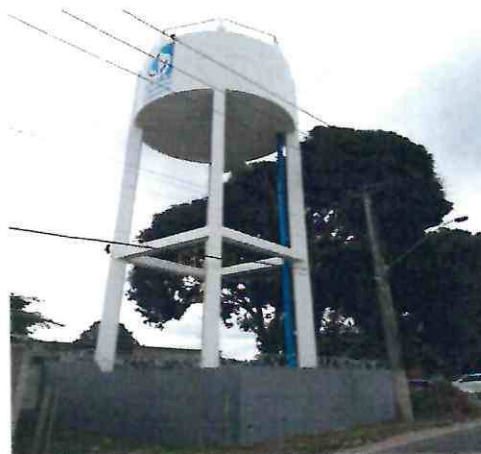
Reservatório Elevado - Canivete
