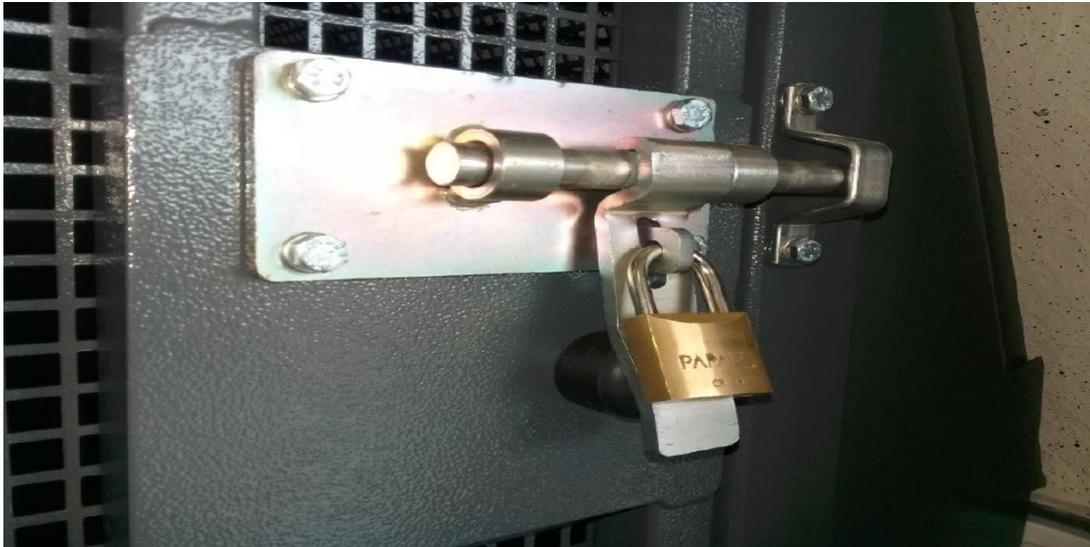
Figura 12: Trinco para o fechamento, com batente de borracha da cela
