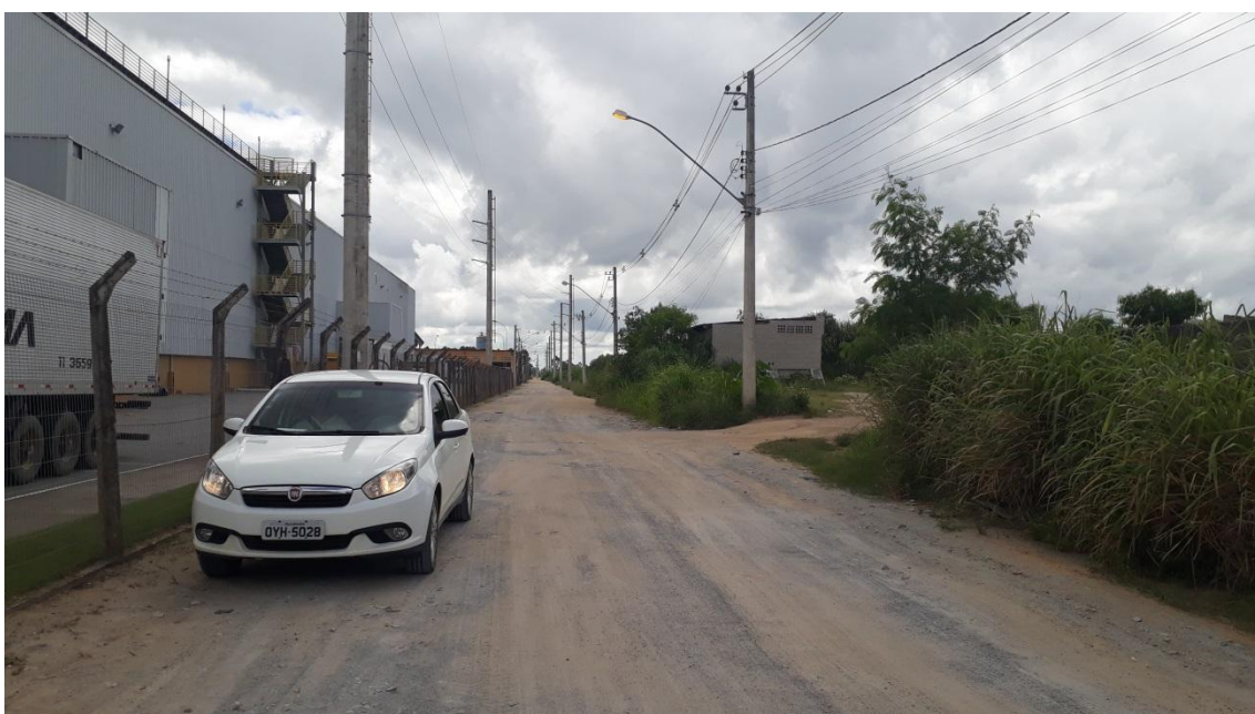
Imagem 24 - Trecho da Rua Nivaldo Alberto Salles, sentido Loteamento Empresarial Giuclube, não possui pavimentação ou sinalização.
