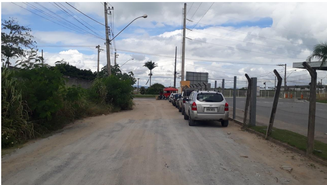
Imagem 23 - Trecho da Rua Nivaldo Alberto Salles, sentido BR 101, não possui pavimentação.
