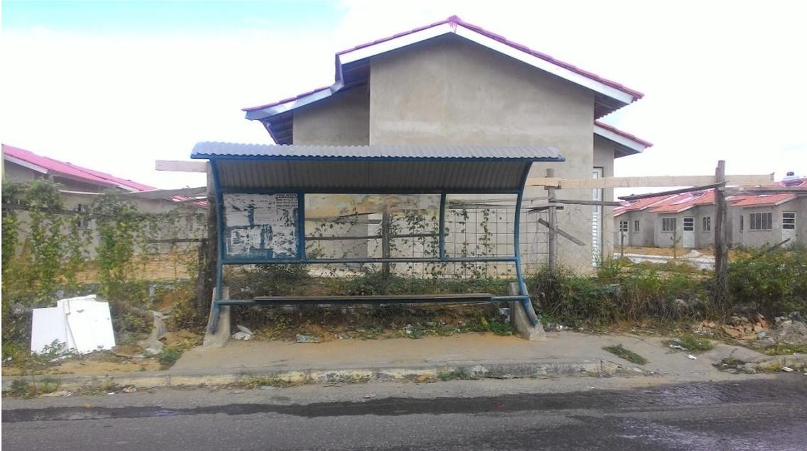
Imagem 07 - Ponto de ônibus 06 - A acessibilidade ao ponto não atende ao exigido na NBR 9050 - Acessibilidade a edificações, mobiliário, espaços e equipamentos urbanos.
