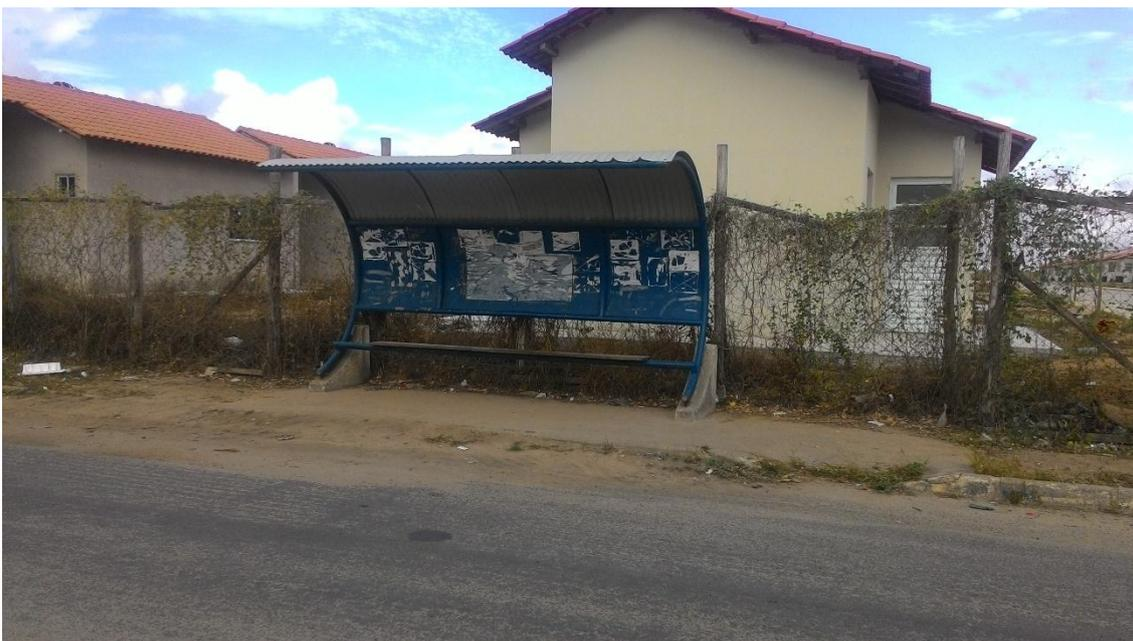
Imagem 05 - Ponto de ônibus 04 - A acessibilidade ao ponto não atende ao exigido na NBR 9050 - Acessibilidade a edificações, mobiliário, espaços e equipamentos urbanos.
