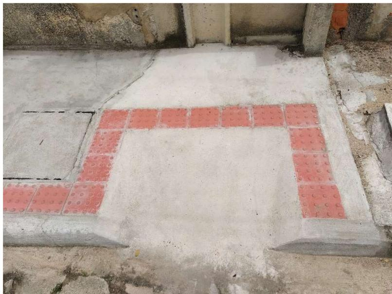
Figura 39 - Rampa deficiente ponto de parada de ônibus 01 – Em desacordo com a NBR9050
