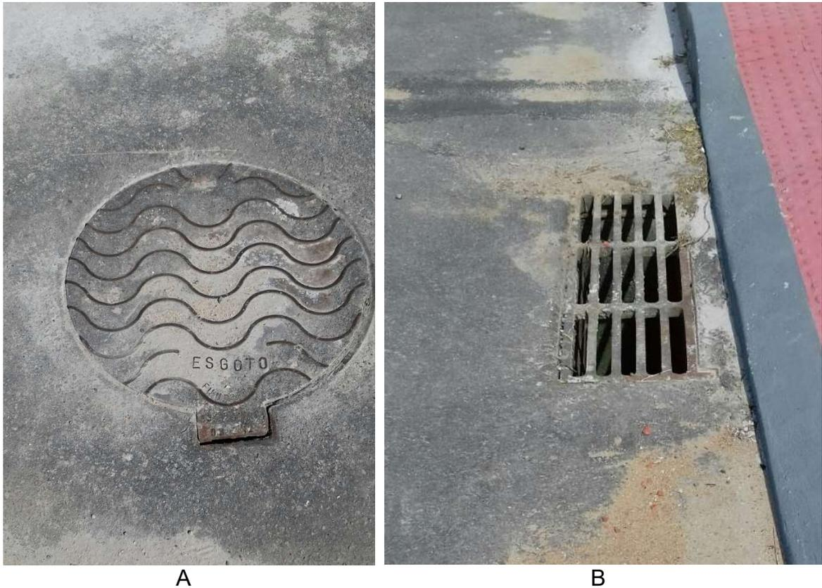
Figura 109 - Fotos caracterizando a infraestrutura de saneamento do loteamento Lagoa Park I; A – poço de visita da rede de esgotamento sanitário; B – bueiro para drenagem pluvial.
