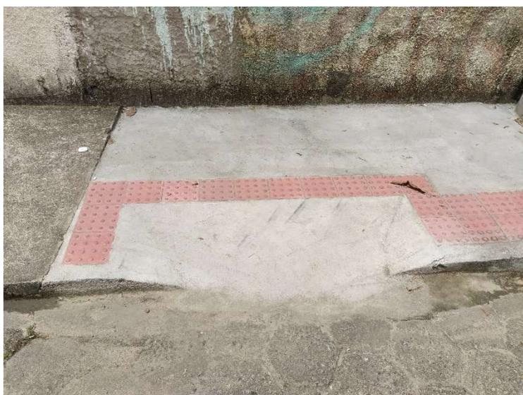
Figura 42 - Rampa deficiente ponto de parada de ônibus 05 – Em desacordo com a NBR9050
