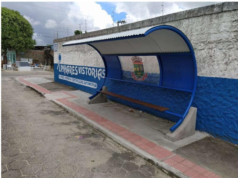
Figura 45 - Pontos de parada de ônibus 08 (sentido empreendimento) com rampa em desacordo com a NBR 9050.
