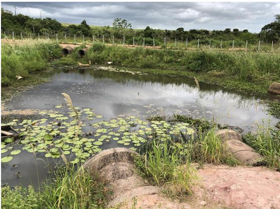
Figura 136. Ponto de passagem da água manilhada proveniente da área de alagadiço.
