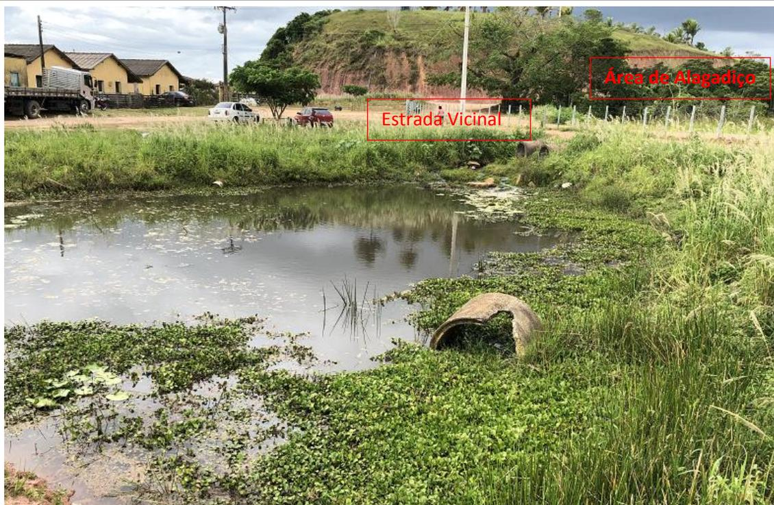
Figura 135. Ponto de passagem após manilhamento da área de alagadiço em relação a estrada vicinal e o corpo hídrico.
