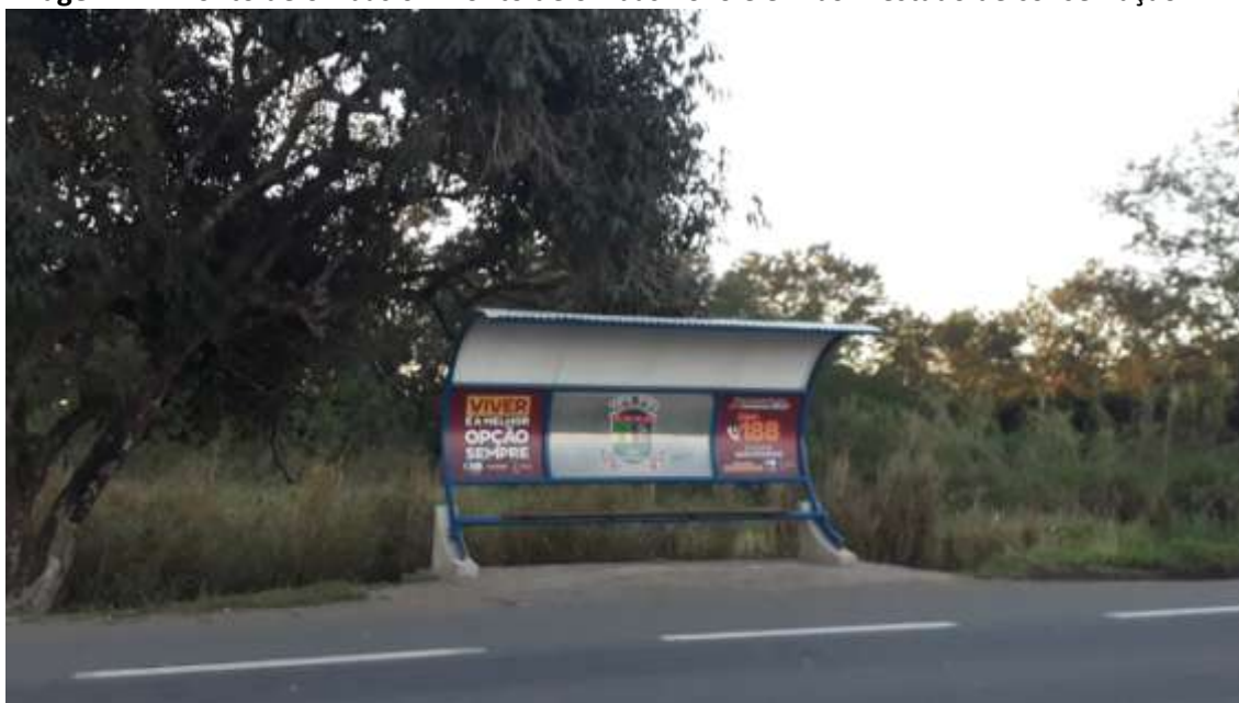
Imagem 24 - Ponto de ônibus 04. Ponto de ônibus novo e em bom estado de conservação.
