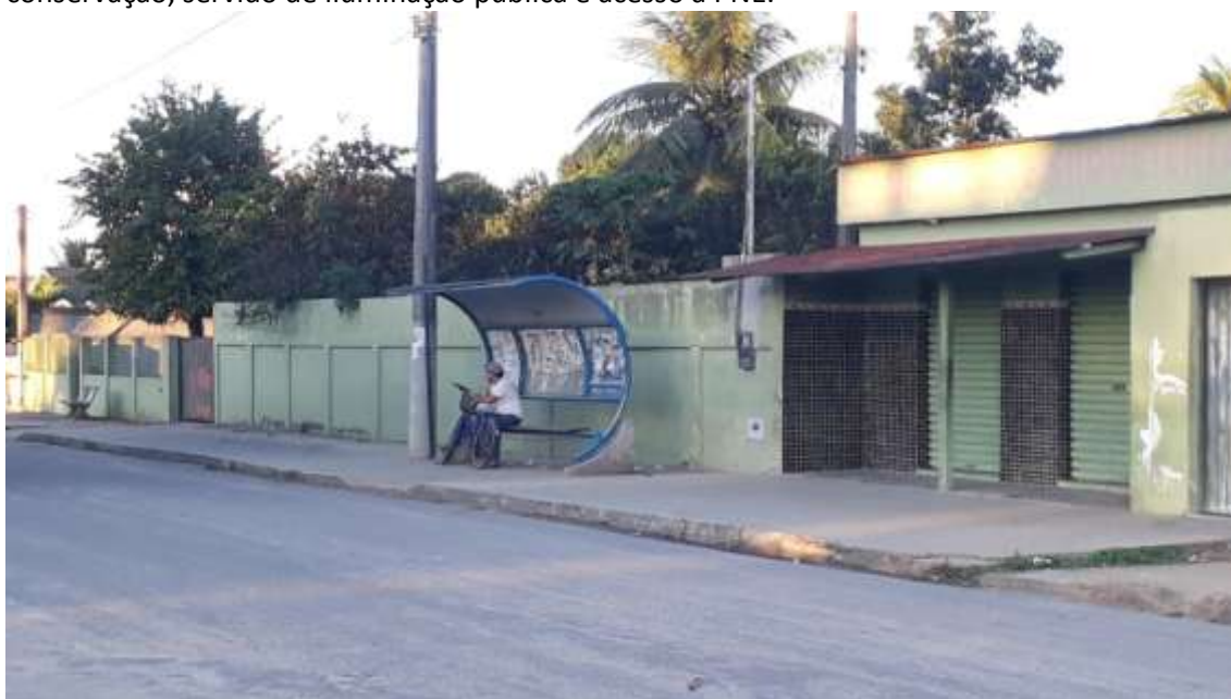
Imagem 28 - Ponto de ônibus 15 – Em Rio Quartel. Ponto de ônibus em bom estado de conservação, servido de iluminação pública e acesso a PNE.
