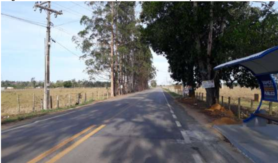
Imagem 12 – Acesso à rodovia ES 440 apresentando boa sinalização viária horizontal e vertical
