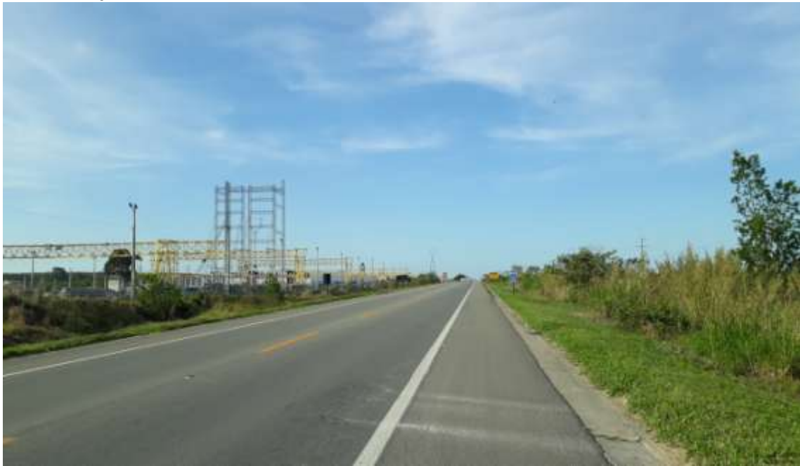
Imagem 16 – Trecho da BR 101 em frete a Brametal – Acostamento de ambos os lados da via, boa sinalização viária horizontal e vertical.
