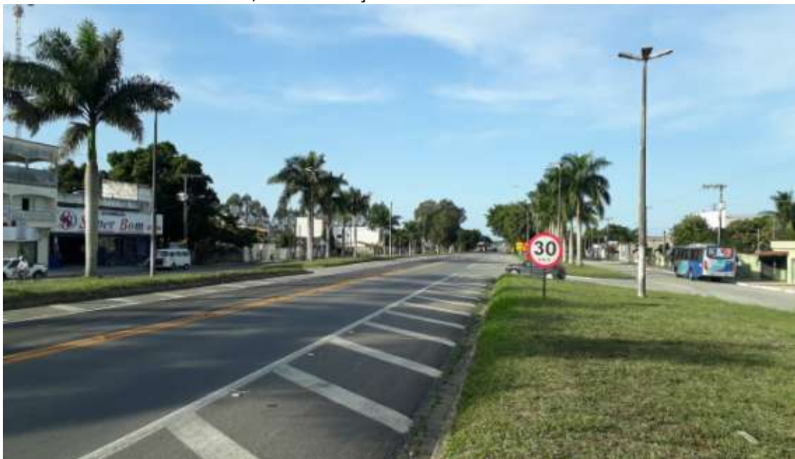
Imagem 17 - Trecho da BR 101 no distrito de Rio Quartel – Faixa de aceleração e desaceleração em ambos os lados da rodovia, boa sinalização viária horizontal e vertical.
