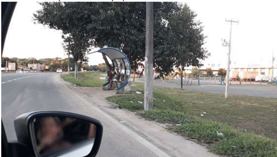
Imagem 21 - Ponto de ônibus 01- Entrada de Bebedouro. Ponto de ônibus novo, em bom estado de conservação e com iluminação publica satisfatória.
