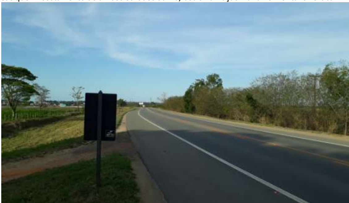
Imagem 13 – BR 101 - Porção de terreno frontal a área pretendida para o projeto da Cia Cacique - Acostamento de ambos os lados da via, boa sinalização viária horizontal e vertical
