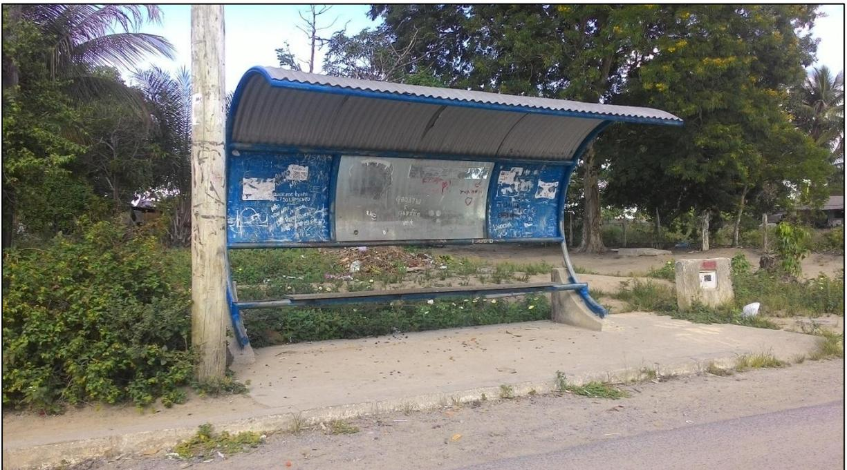
Imagem 13 - Ponto de ônibus 01 – Ponto com estrutura e iluminação em boas condições, e acessibilidade em desacordo com NBR 9050.
