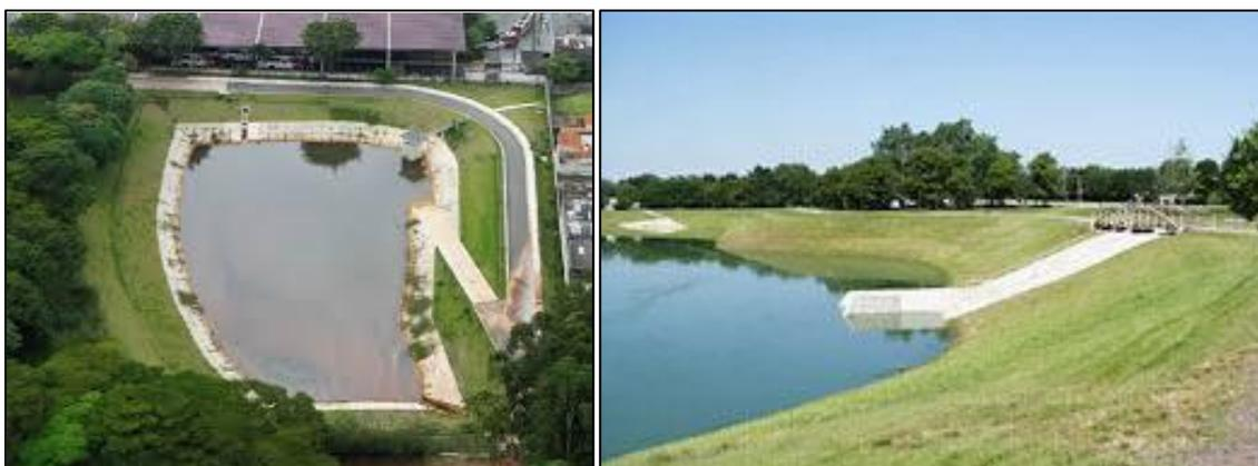
Figuras 53 e 54 - exemplos de reservatório de detenção.
