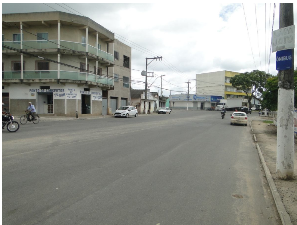
Foto 20 – Interseção 2, esquina Av. Filogonio Peixoto e Av. Conceição da Barra com pouca sinalização.
