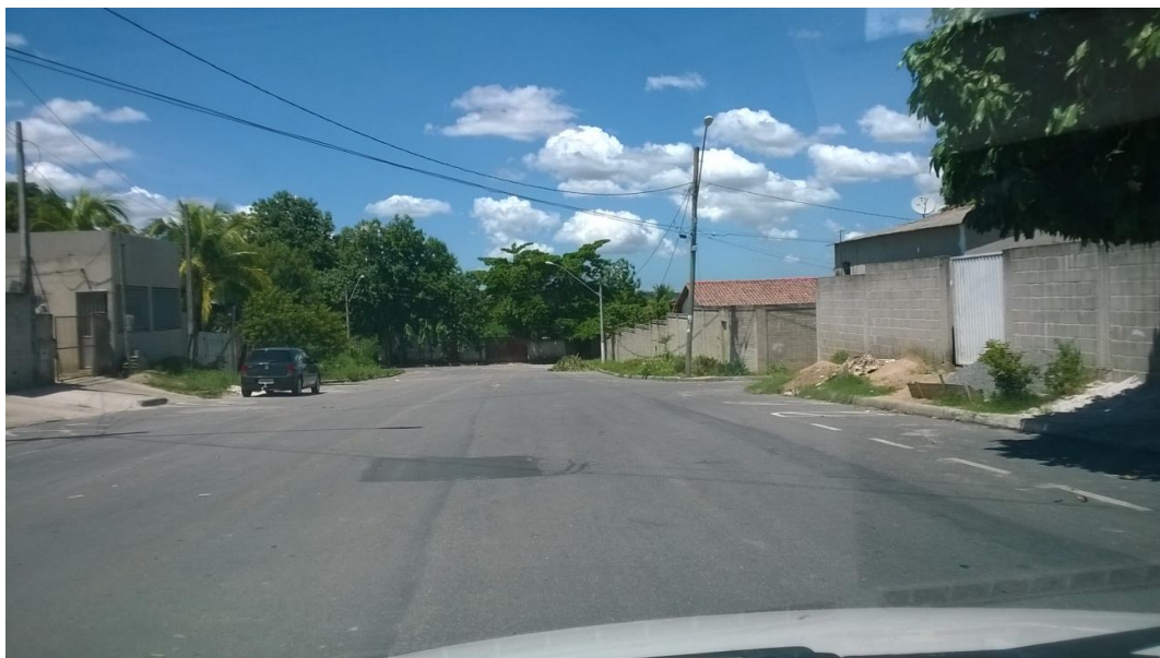
Foto 10 – Outra vista do final da Av. Vasco Fernandes Coutinho no Bairro Interlagos, local onde futuramente estaria o início da Ponte para ligar a ES-248 de lado do loteamento.
