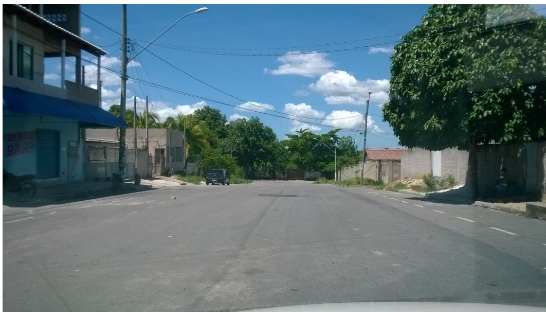
Foto 09 – Final da Av. Vasco Fernandes Coutinho no Bairro Interlagos, local onde futuramente estaria o início da Ponte para ligar a ES-248 de lado do loteamento.
