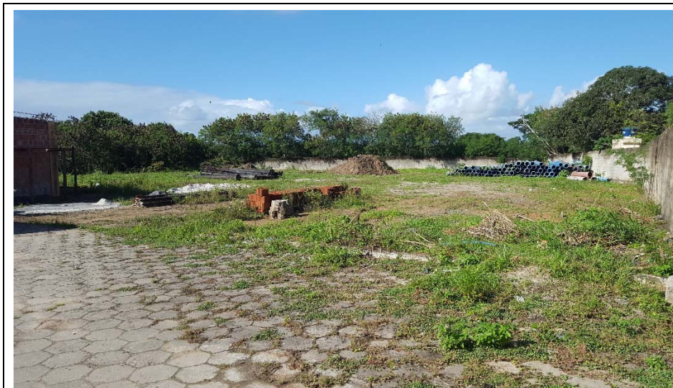
Foto 4: Área de Implantação da Expansão da ETE do Aviso
