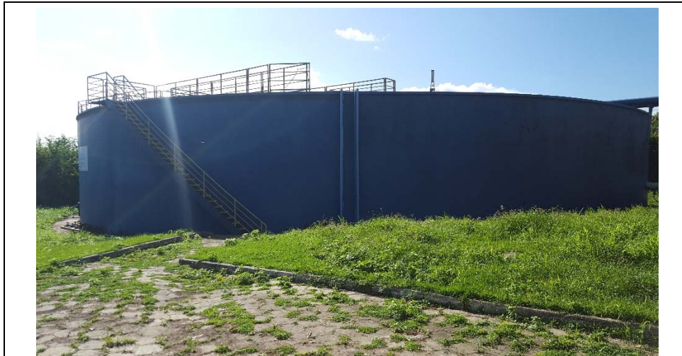
Foto 3: Estação de Tratamento de Esgoto
